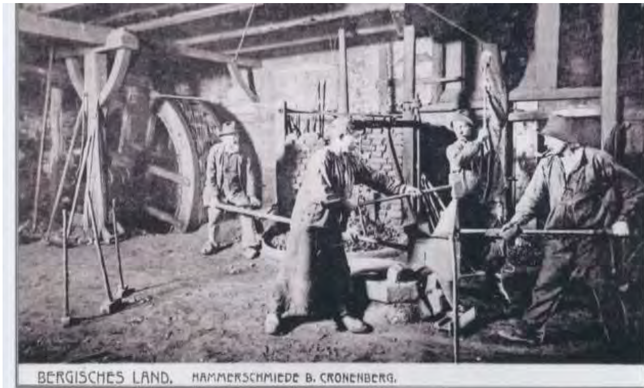
Das Amboßhorn wird feuerverschweißt
