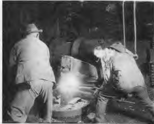
Glühendes Eisen wird unter den Wasserhammer gebracht.
