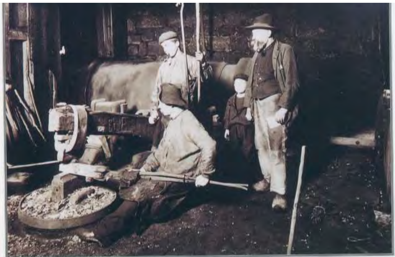
Ein Amboßhorn wird vorgeformt
