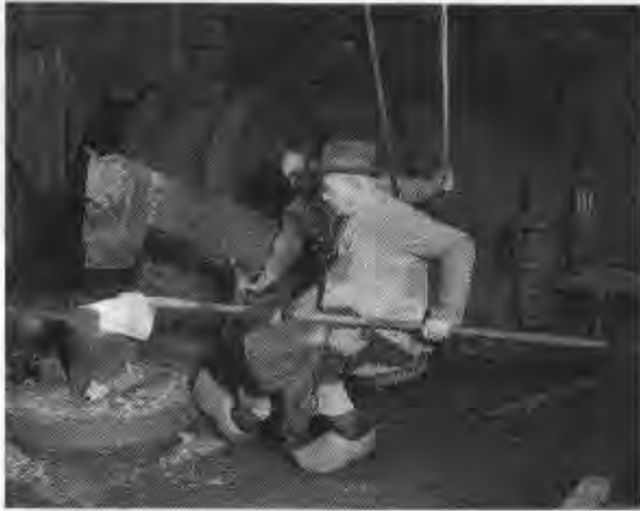
Ein Amboßhorn wird vorgeformt . . .
