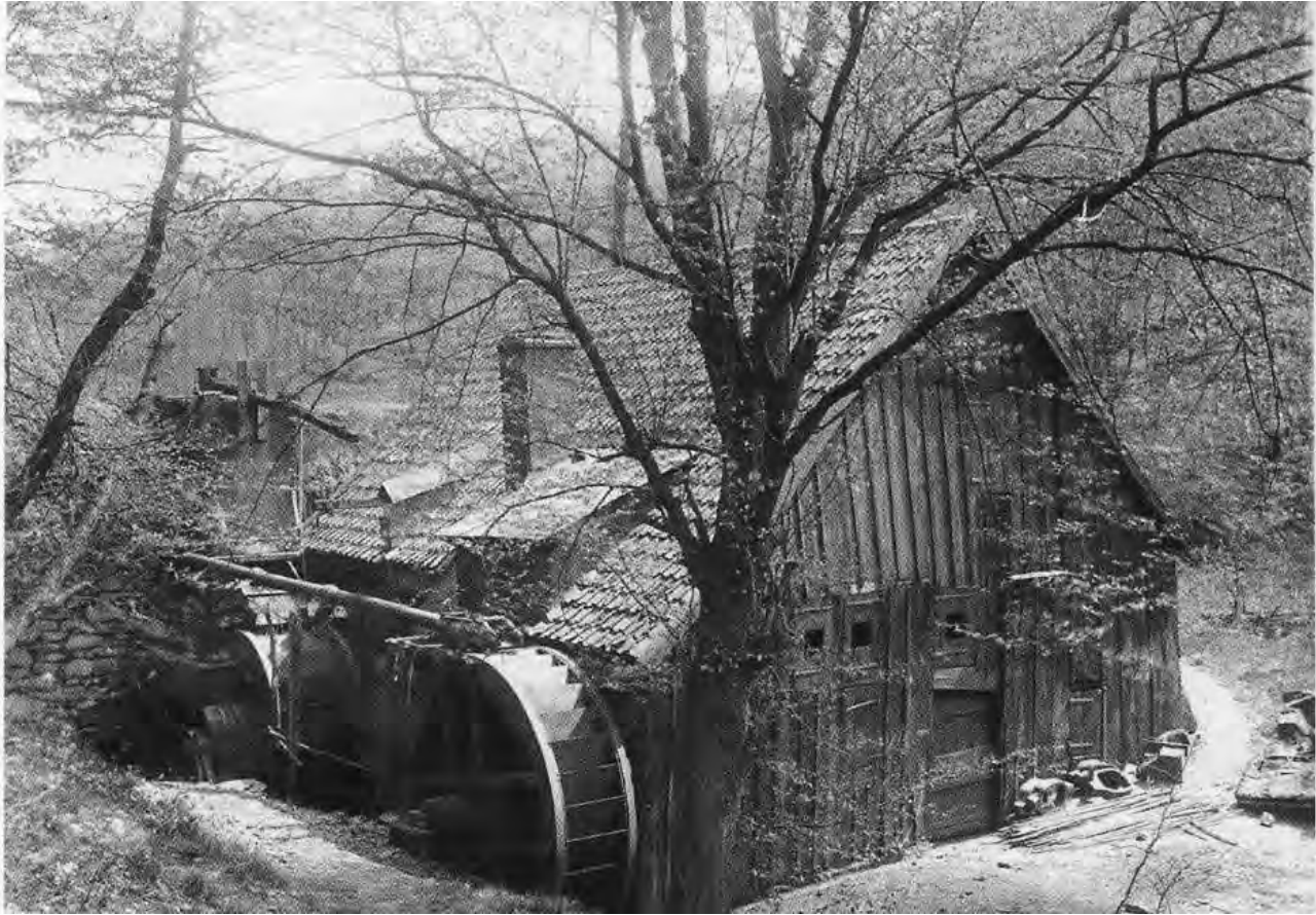
Wasserhammer mit zwei überschlächtigen Wasserrädern
