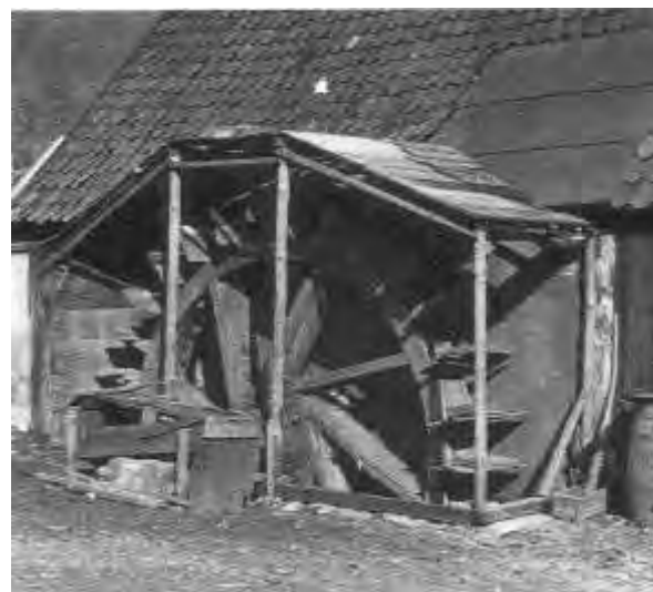
Unterschlächtiges Wasserrad Wasserantrieb von unten
