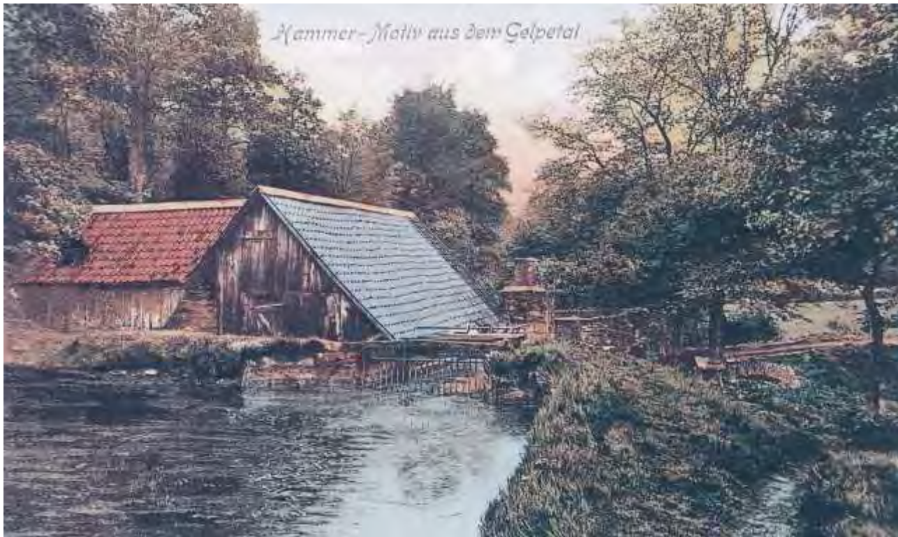
Wasserhammer mit Hammerteich
