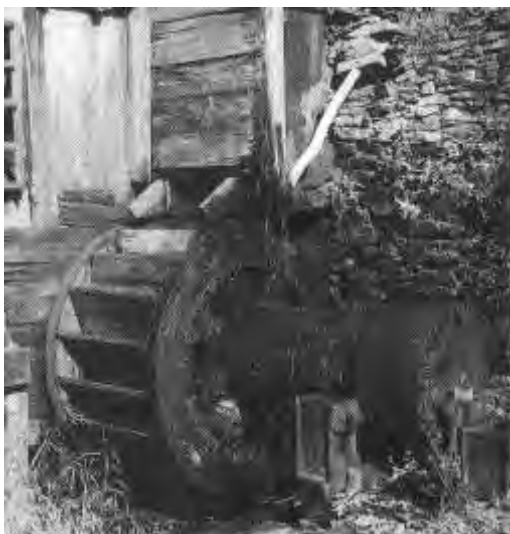
Oberschlächtiges Wasserrad Wasserantrieb von oben
