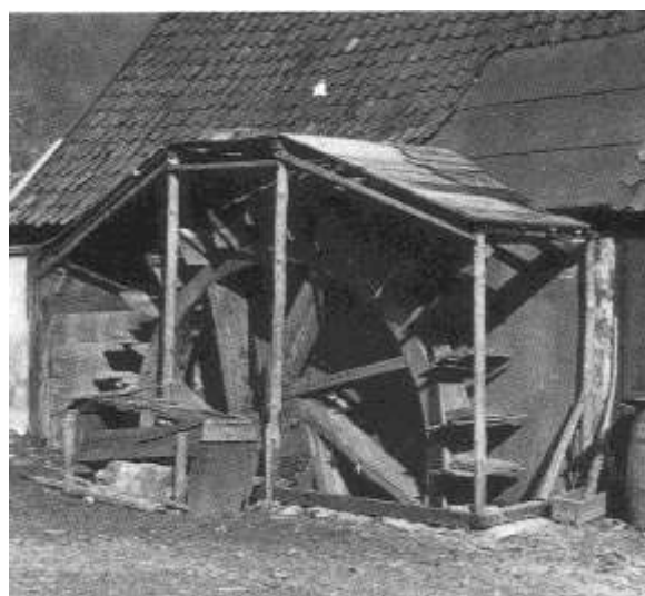
Unterschlächtiges Wasserrad Wasserantrieb von unten
