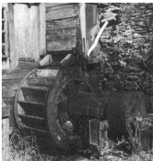
Oberschlächtiges Wasserrad Wasserantrieb von oben
